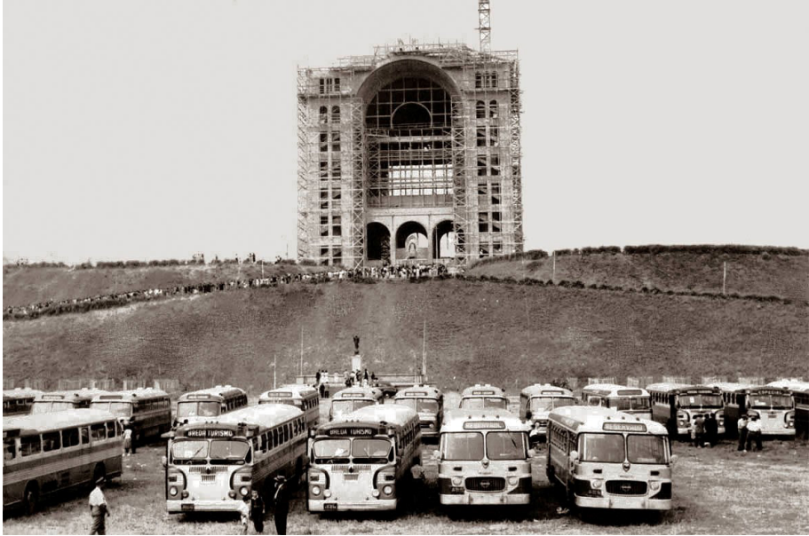
Figura 3 – Aparecida, construção da nova basílica na década de 1960. Fonte: Centro Documentação e Memória Santuário Nacional
