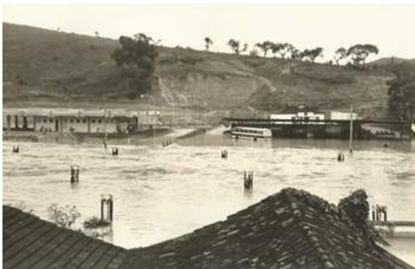
Figura 7 – Enchente na rodoviária de Ubá, em 1977.
