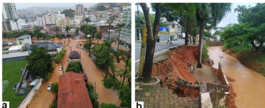
Figura 13: Inundação e processos erosivos ao longo do segmento retificado. a – Inundação provocada pelo Ribeirão Ubá em 24/01/2020. Fonte: G1 Zona da Mata (2020); b – Erosão nas margens do Ribeirão Ubá, Centro de Ubá em 11/02/2020. Foto: Silva, 2020.
