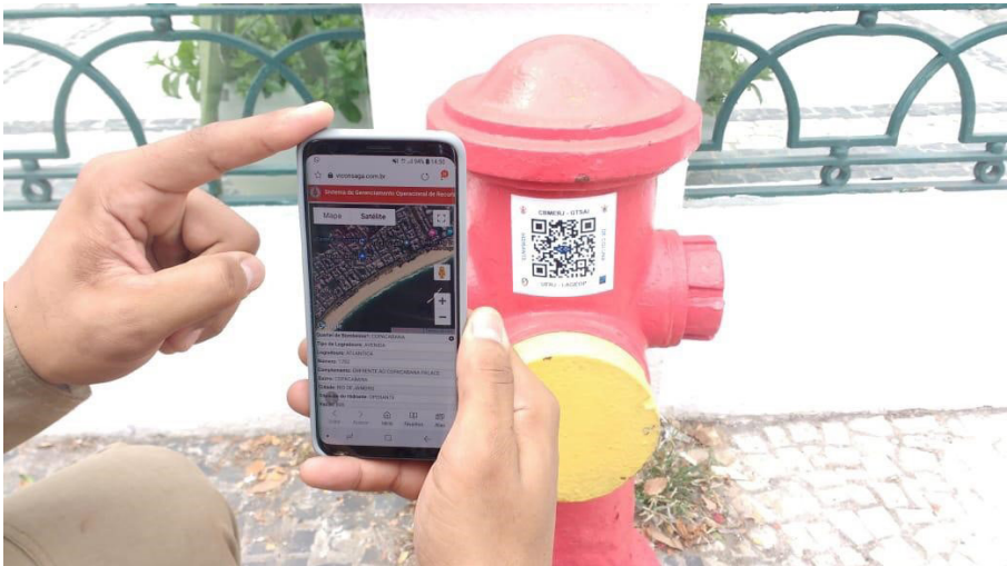
Figura 5 – Hidrante de coluna localizado em frente ao Hotel Copacabana Palace, no bairro de Copacabana (RJ) com QRCode para acesso direto aos seus atributos (condição de operação, vazão, batalhão responsável, data da última vistoria etc.).
