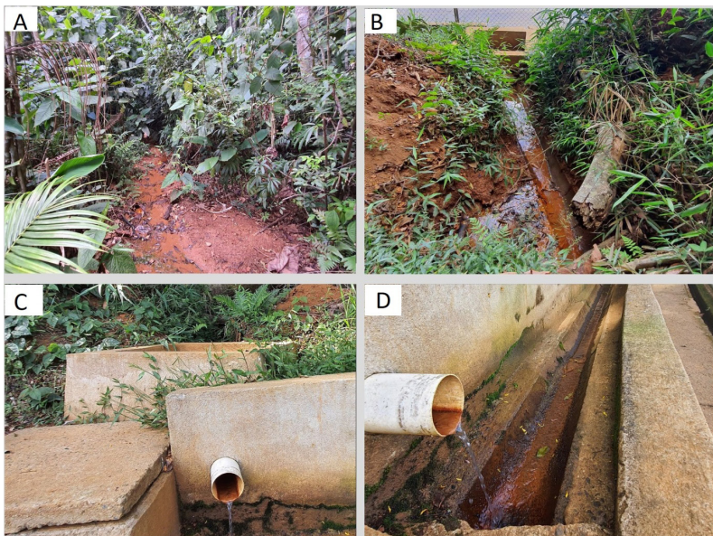
Figura 4 – UF20. 4A – Vista o mais a montante possível da nascente. Por ela ser difusa, forma um pequeno brejo, de difícil acesso. 4B, C e D – Poucos metros depois de sua exfiltração, sua morfologia é alterada, passando a drenar em uma canaleta, até desaguar no canal principal, a sua jusante.
