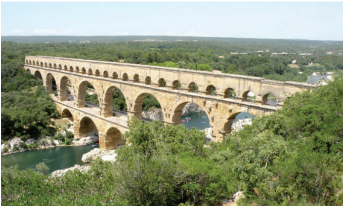
Figura 8 – Arqueduto Port Du Gard.
