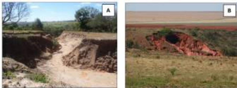
Figura 9 – A – Área degradada por processos erosivos em Ravinas em áreas de Neossolos na comunidade de Charbou, município de Jauru – MT; B – Erosão em Voçoroca em Argissolos em áreas de agricultura no município de Tangará da Serra – MT.
