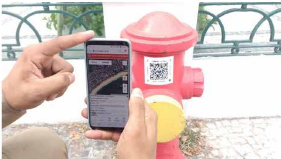
Figura 5 – Hidrante de coluna localizado em frente ao Hotel Copacabana Palace, no bairro de Copacabana (RJ) com QRCode para acesso direto aos seus atributos (condição de operação, vazão, batalhão responsável, data da última vistoria etc.).
