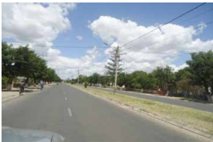
Figura 5 – Av. Principal de Mocuba e muros de vedação.
