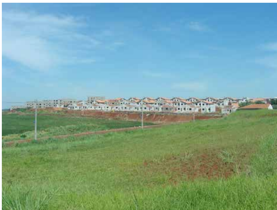
Figura 6 – Maringá. Residencial Dolores Duran (em fase de construção). 2011. Fonte: http://www.panoramio.com/photo/67100738 . Acesso em: 13 set. 2013.
