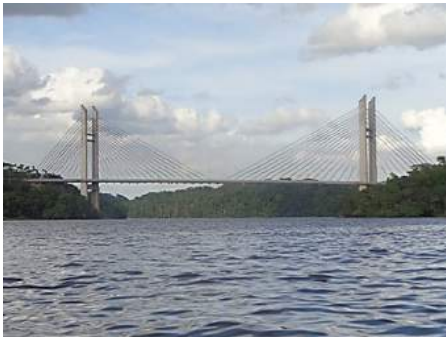
Figura 2 – Ponte Binacional Sobre o Rio Oiapoque.
