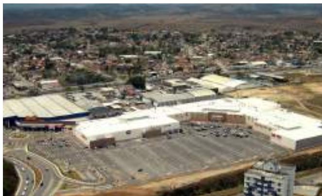
Figura 8 – Vista aérea do complexo com o shopping center Pátio Mix e o hipermercado Spani, localizado junto ao principal acesso viário de Resende e à Rodovia Presidente Dutra (acima do hipermercado). Sem data.
