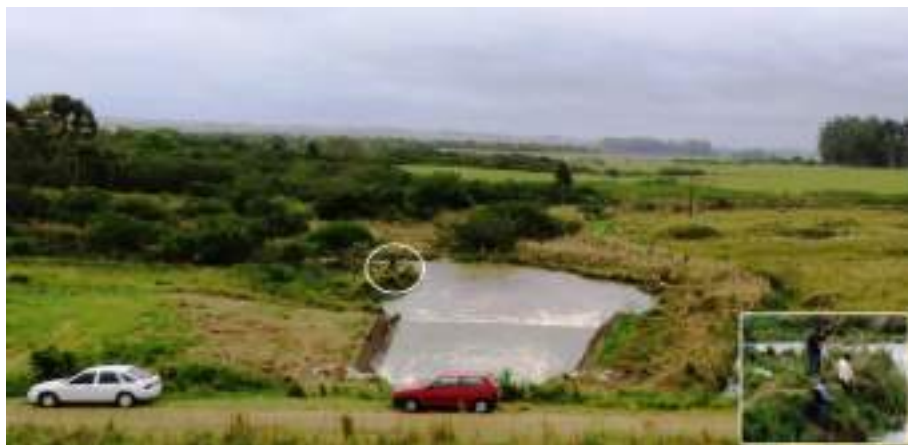
Figura 6 – Local de Saída de Água da Barragem do Capané (Vertedouro).
