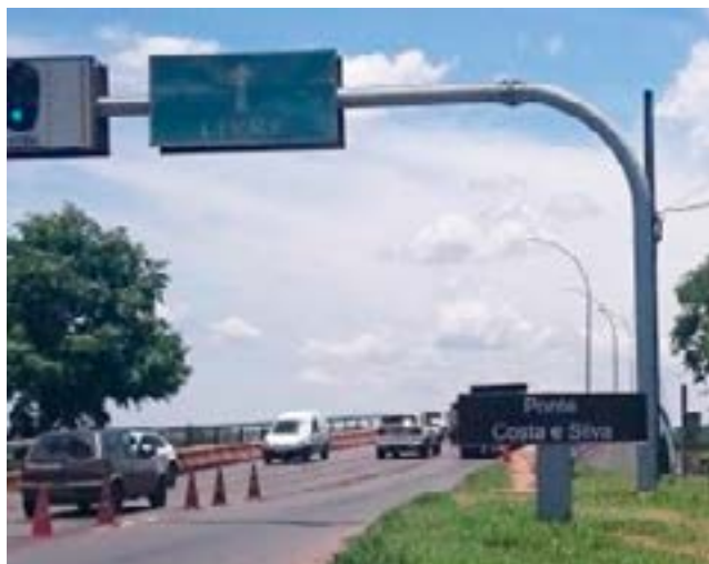
Fig. 6 Intervenção “ponte Costa e Silva”. Fonte: (GALLO, 2015)
