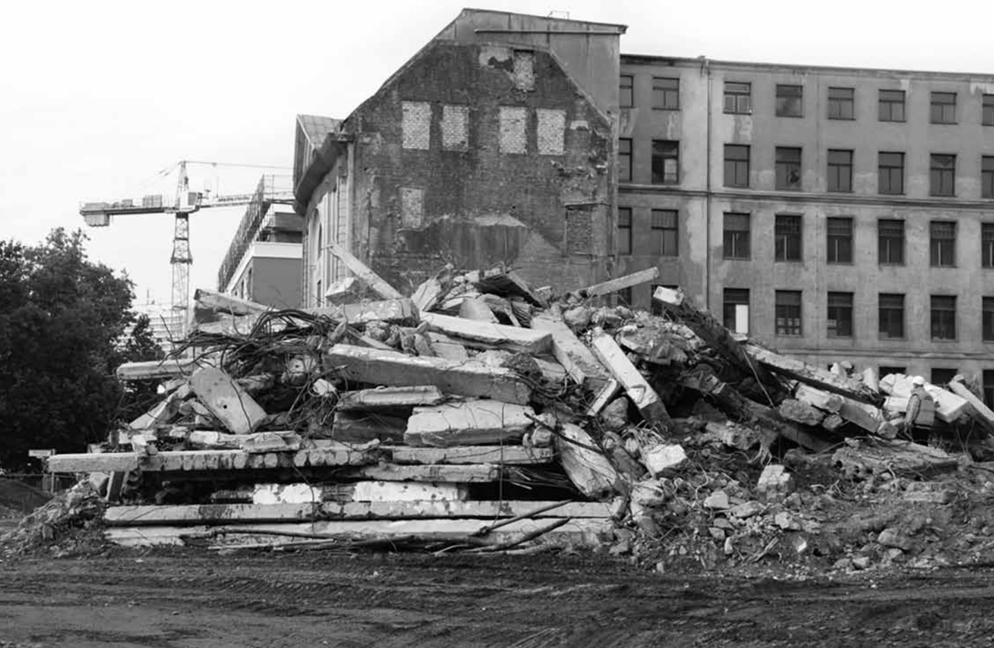
Demolição do antigo Ministério da Construção da RDA Abrissarbeiten des ehemaligen Bauministeriums der DDR Berlim Foto © Stefanie Bürkle/VG Bild-Kunst
