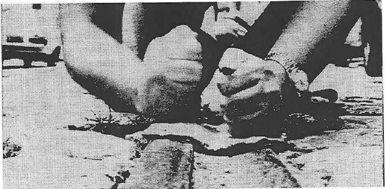
Foto 20: Imprimindo os trilhos de bonde à Rua Francisco Muratori.
