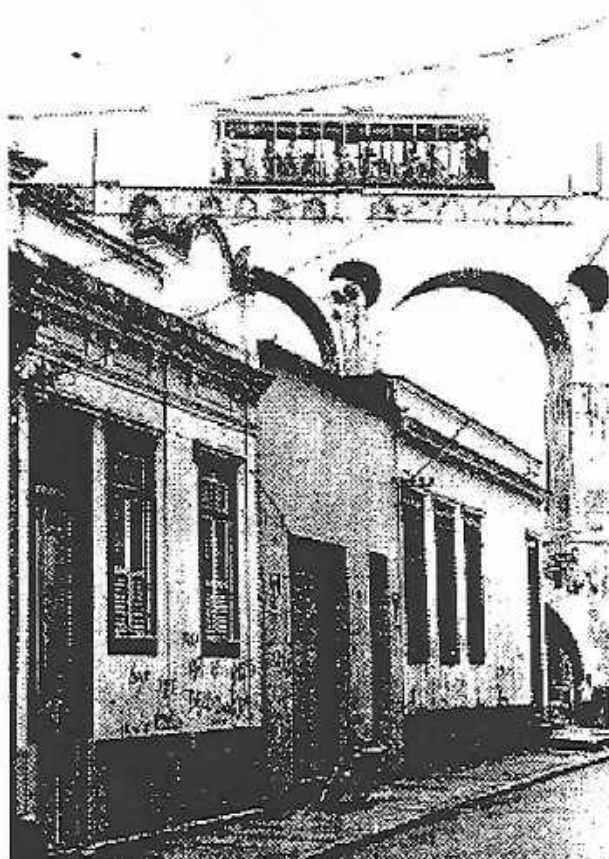
Foto 21: Joaquim Silva, 141. Casa de esquina onde hoje funciona um bar. No encontro com os arcos a rua se despoja e recupera a tipologia colonial.
