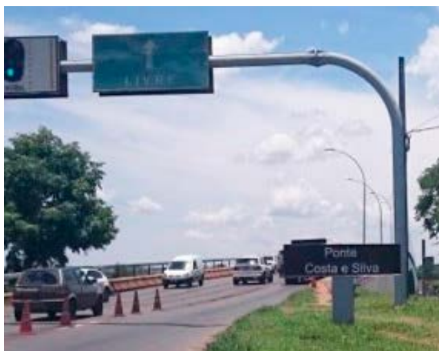
Fig. 6 Intervenção “ponte Costa e Silva”. Fonte: (GALLO, 2015)
