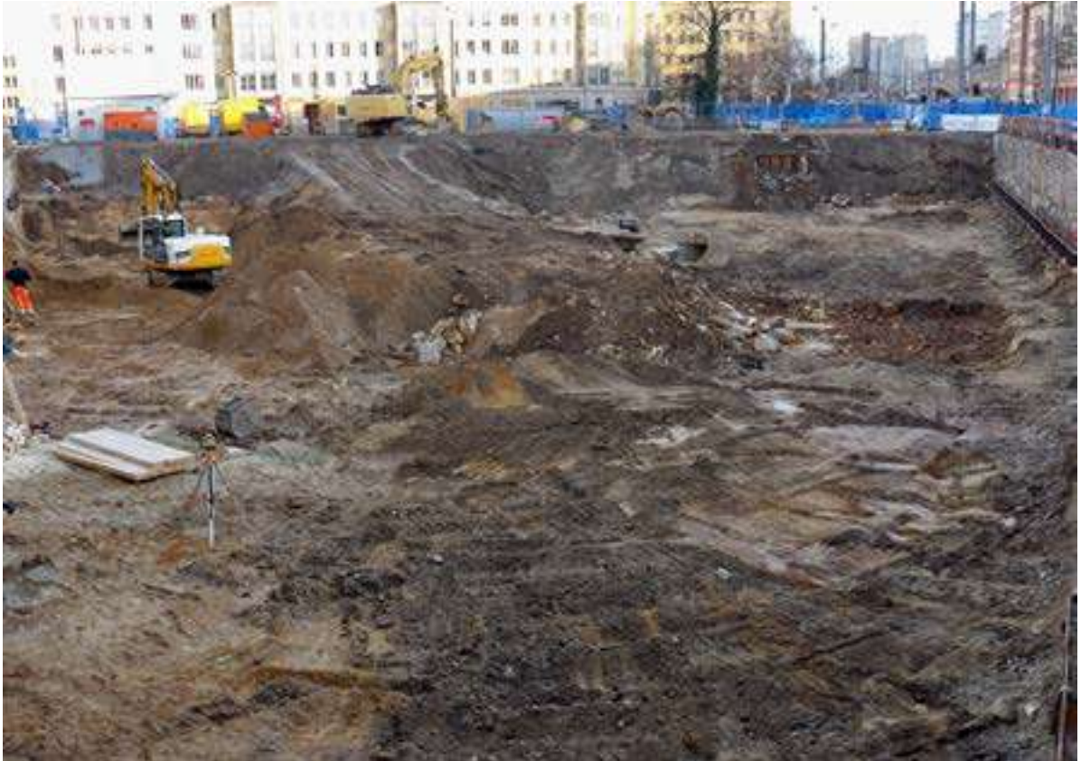
Figura 12 Escavação parada em Leipzig, 2024
