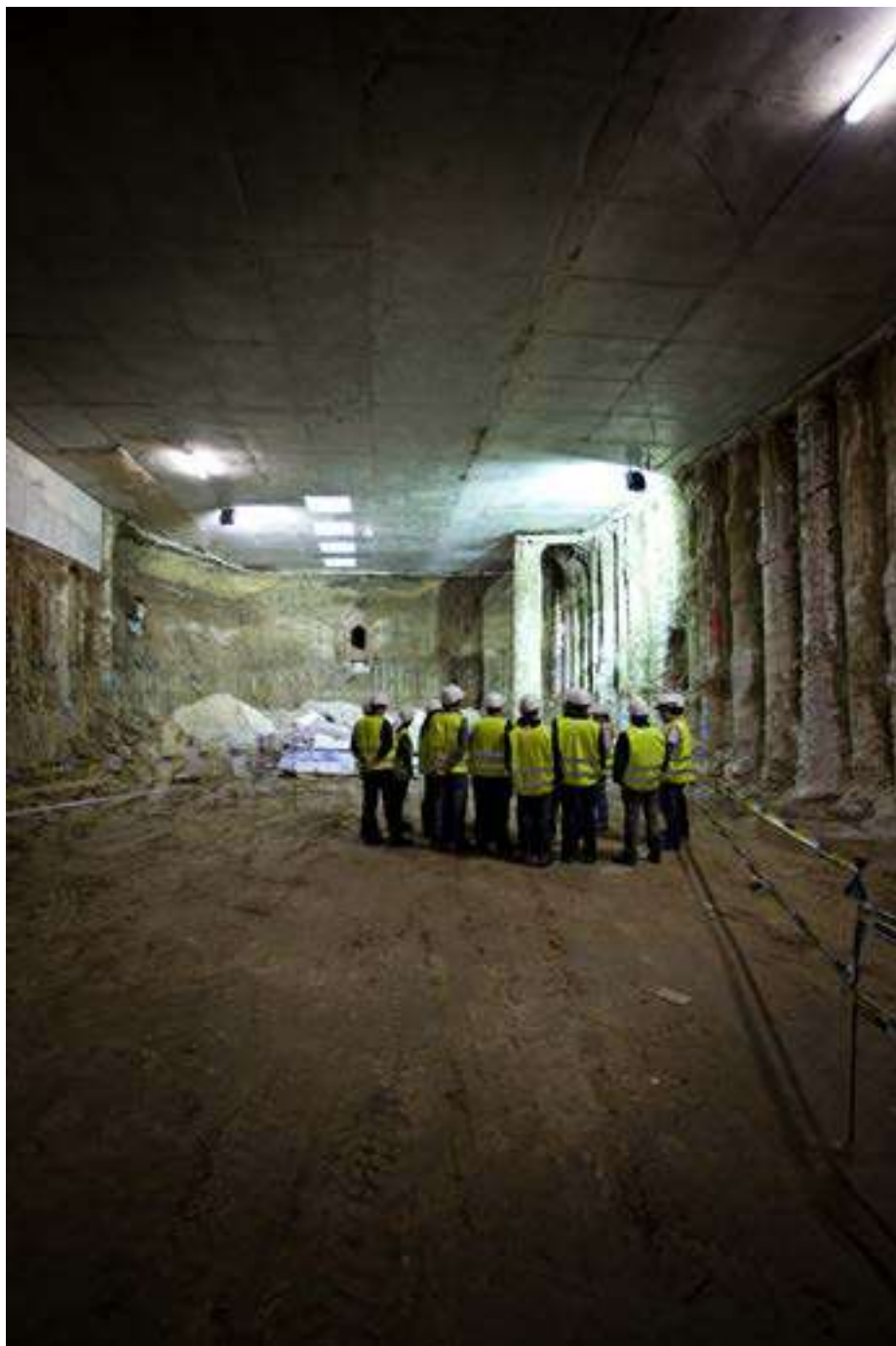
Figura 17 Descendo em um túnel recém-escavado, Madri, 2010
