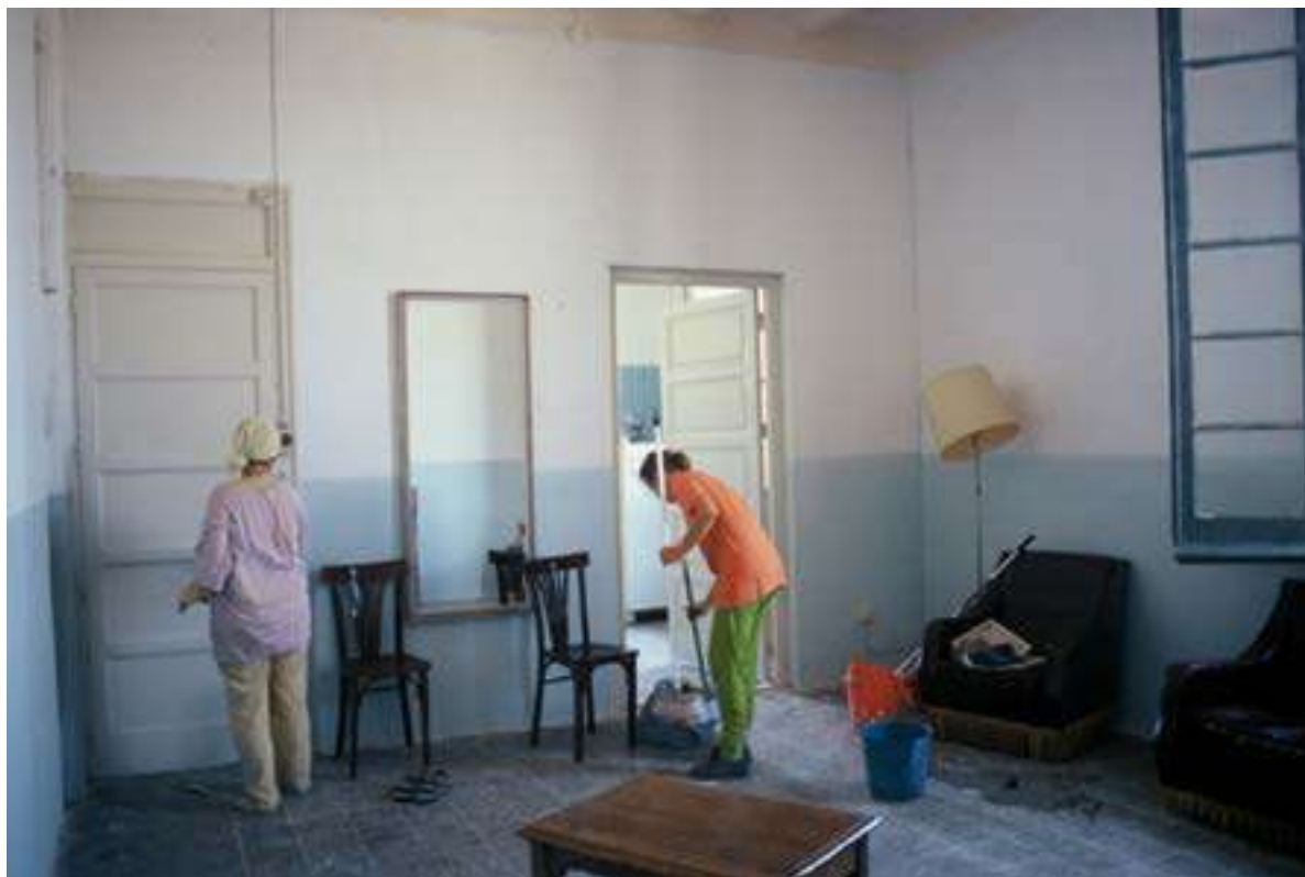
Figura 2 Hotel de Fuentes de Ebro, estação de trem de Fuentes de Ebro, próximo de Zaragoza, 1997 Projeto em colaboração com Begoña Movellán
