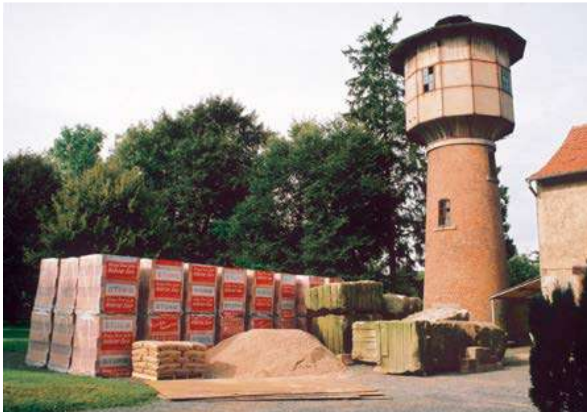
Figura 3 Materiais de construção da caixa d'água, Phalsbourg, 2000
