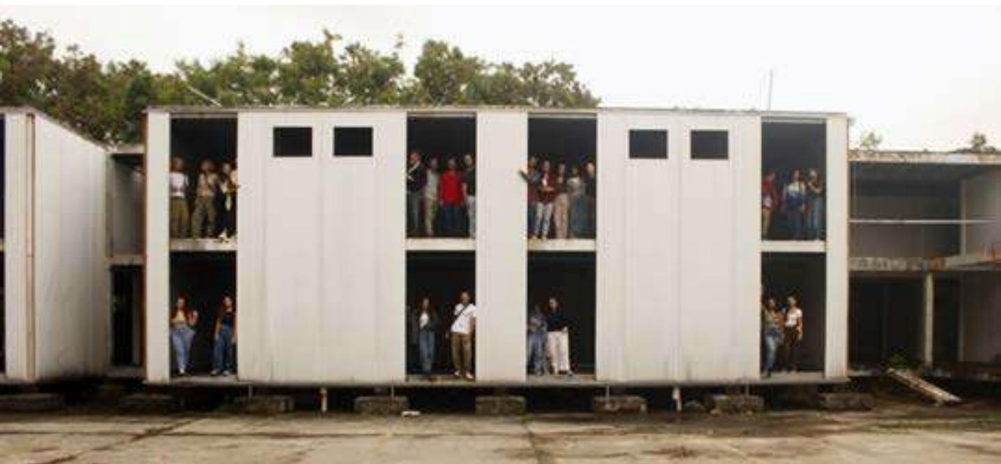
Figura 18 Estudantes finalizam deriva pelo campus da UFRJ em uma estrutura prevista para receber um alojamento provisório de estudantes que teve sua obra interrompida e encontra-se inacabada até hoje
