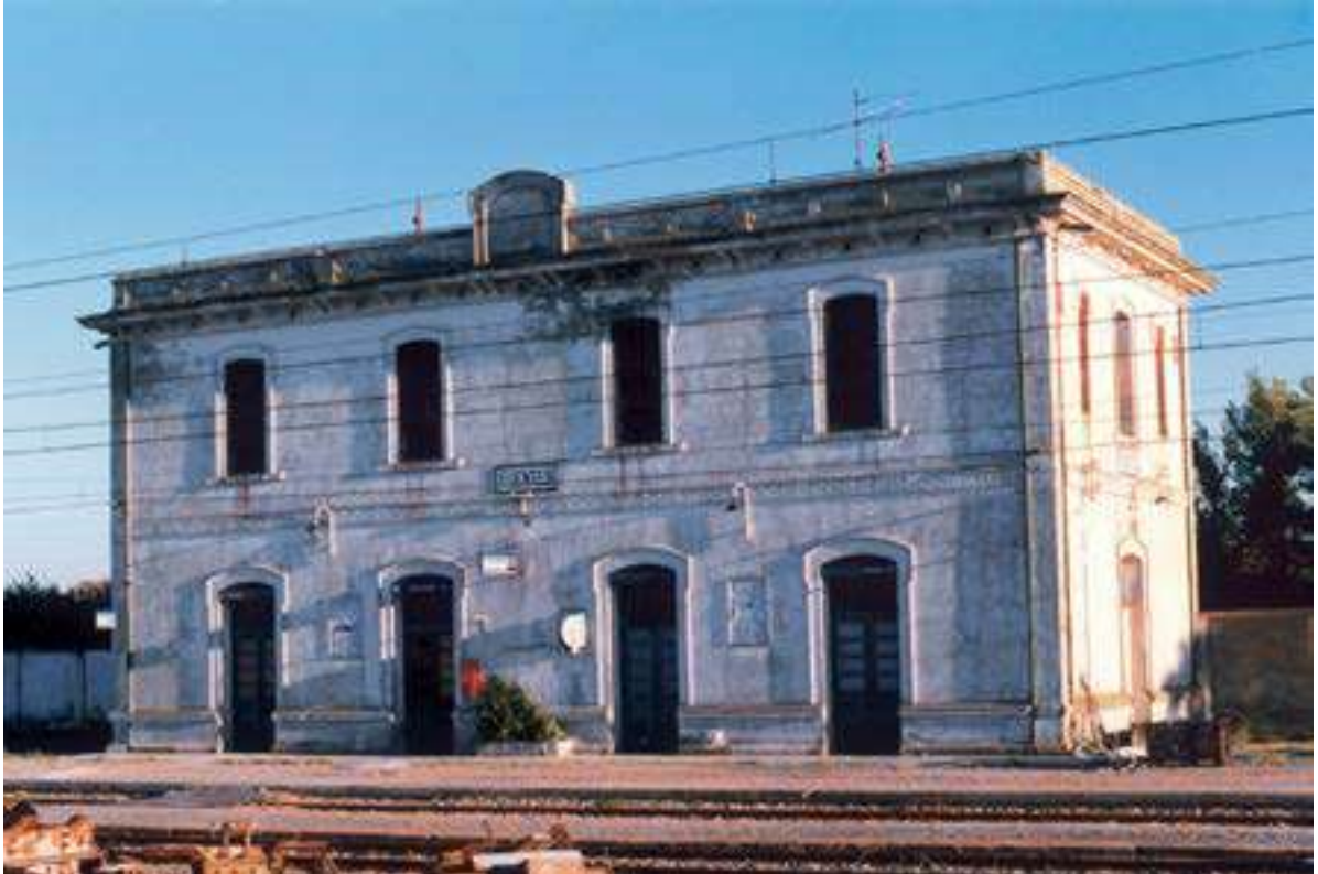
Figura 1 Hotel de Fuentes de Ebro, estação de trem de Fuentes de Ebro, próximo de Zaragoza, 1997 Projeto em colaboração com Begoña Movellán
