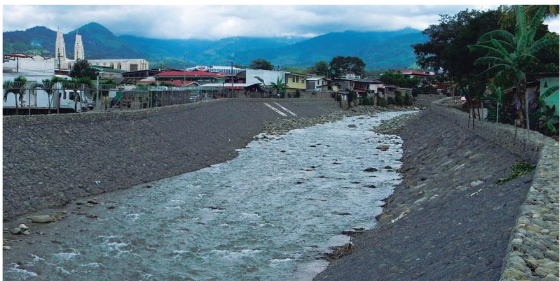
Figura 8 Construcción de diques en los márgenes del río Quebradas en San Isidro del General.
