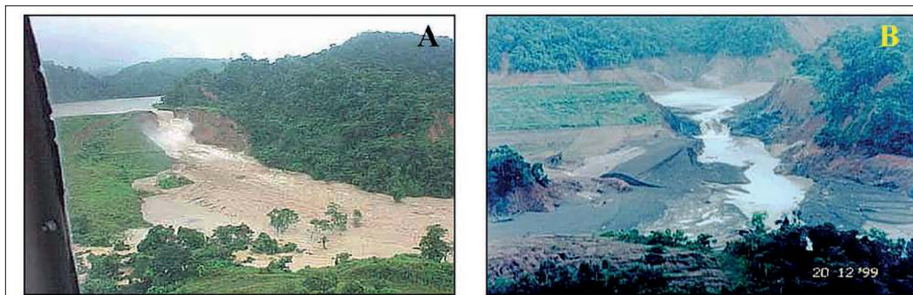
Figura 2 Imágenes del (A) colapso y la onda de agua y del (B) boquete final en el estribo izquierdo (aliviadero) de la pantalla de la presa El Guamito.
