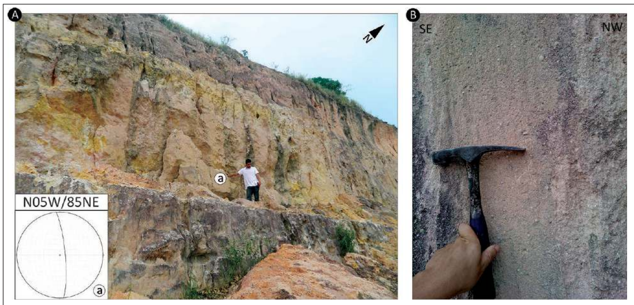
Figura 8 Plano de falha em arenitos da Formação Rio Doce. A) visão geral do plano da falha; B) Detalhe de possíveis feições sugestivas de estrias de atrito slickensides verticais, apresentando direção estrutural consistente ao longo de todo o plano de falha.
