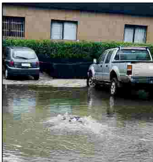
Figura 8 Transbordamento de poço de visita do sistema de esgoto durante alagamento na Rua Agui após evento de precipitação intensa
