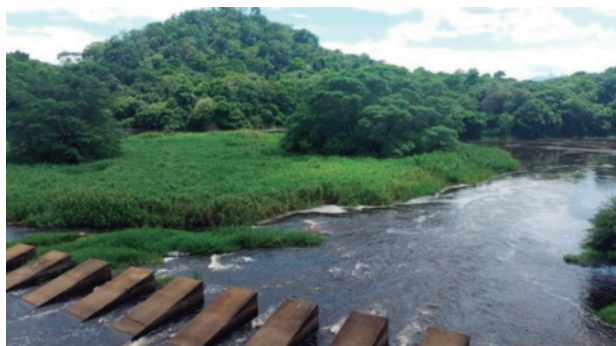
Figura 3 Detalhe das ilhas de sedimentos a jusante e próximas das estruturas da barragem (segundo Rocha & Miranda Neto, 2018).
