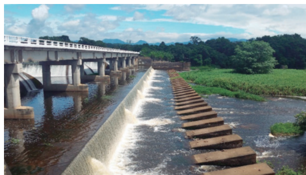
Figura 2 Detalhe das estruturas hidráulicas: vertedouro (a montante da ponte), descarregadores de fundo e dissipadores de energia (Acervo pessoal, 2016).
