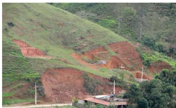
Figura 5 Taludes de corte em encosta de morro alto.
