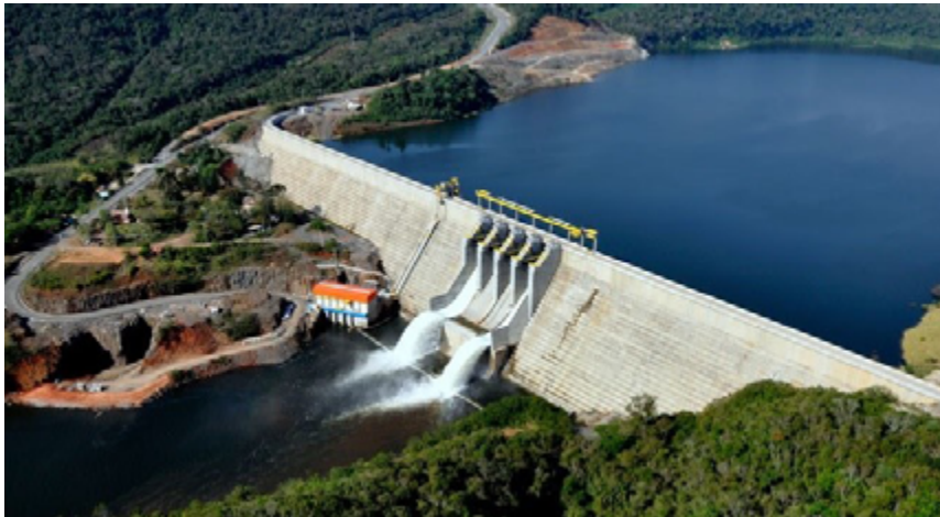
Figura 2 Usina Hidrelétrica de Mauá (COPEL, 2013).
