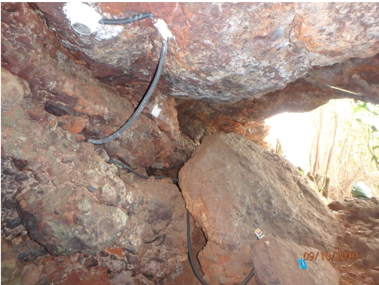
Figura 3 Instalação do Geofone no teto e do Sensor Óptico de Distância na parede da cavidade BRU_0034.
