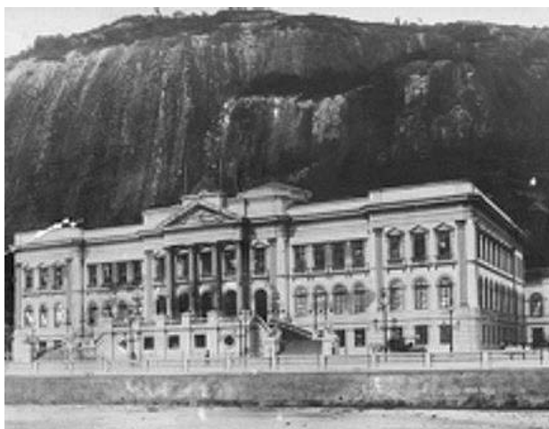
Figura 3 Prédio do DNPM na Praia Vermelha, Rio de Janeiro. Imagem da primeira metade do século passado e do acervo de Arthur Horta (Geólogo da 1ª turma do Rio). O autor é desconhecido.
