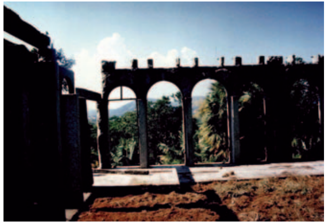
Figura 15 Fachada em construção no SRBM no ano de 1990 (acervo SRBM/IPHAN/MinC).
