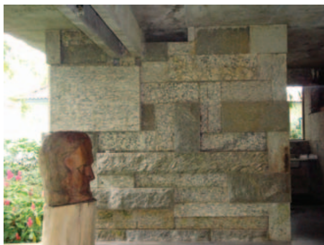
Figura 13 Detalhe da alvenaria de cantaria (acervo SRBM/IPHAN/MinC em 2009).
