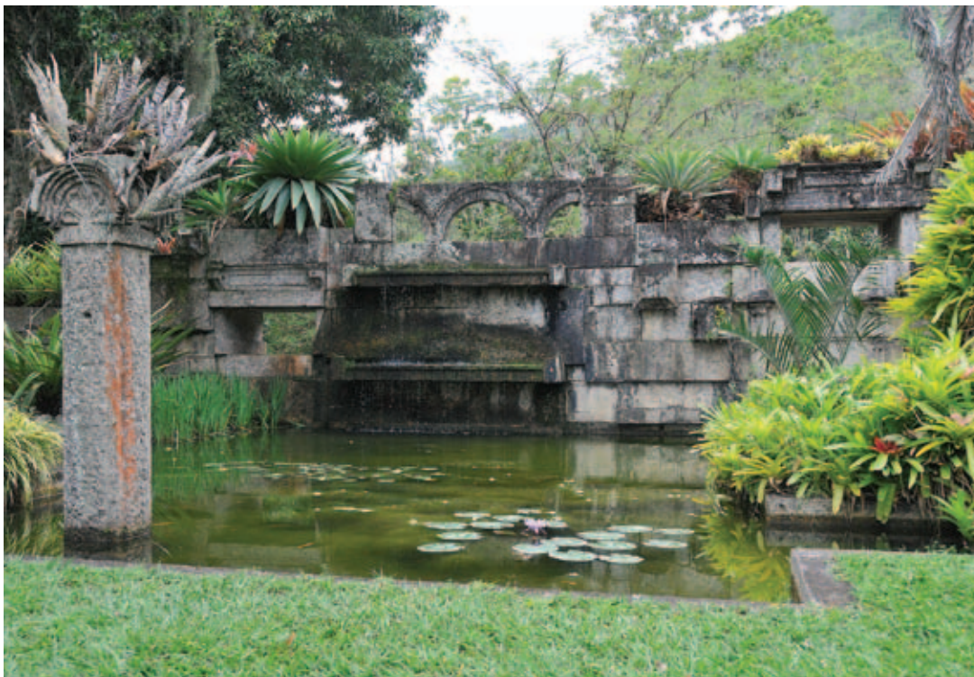
Figura 10 Casa Principal - Muro de arrimo do lago (acervo SRBM/IPHAN/MinC).
