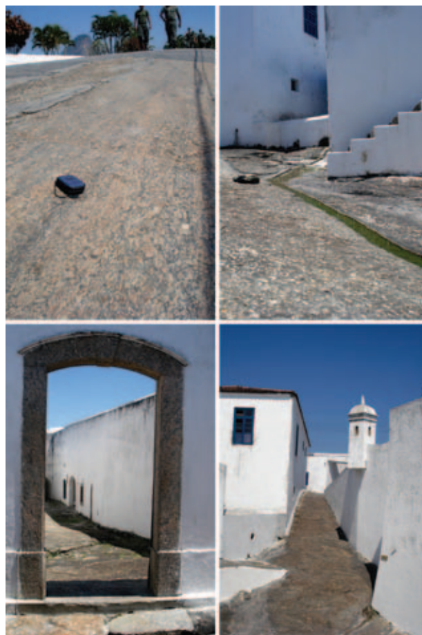
Figura 4 Afloramento esculpido de gnaiss facoidal compo piso no interior da Fortaleza de Santa Cruz.
