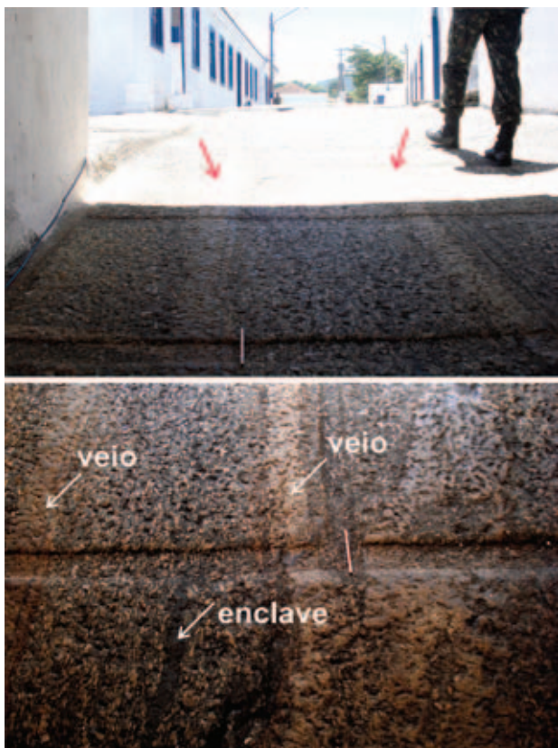
Figura 9 Piso de galeria esculpido diretamente sobre o afloramento de gnaíse facoidal sob a forma de lajotas. Notar enclave de biotita gnaíse acompanhando a foliação.
