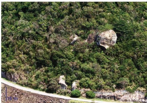
Figura 7 Vista da área antes do escorregamento.
