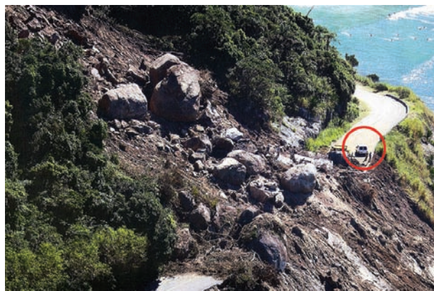
Figura 8 Vista da área após o escorregamento.
