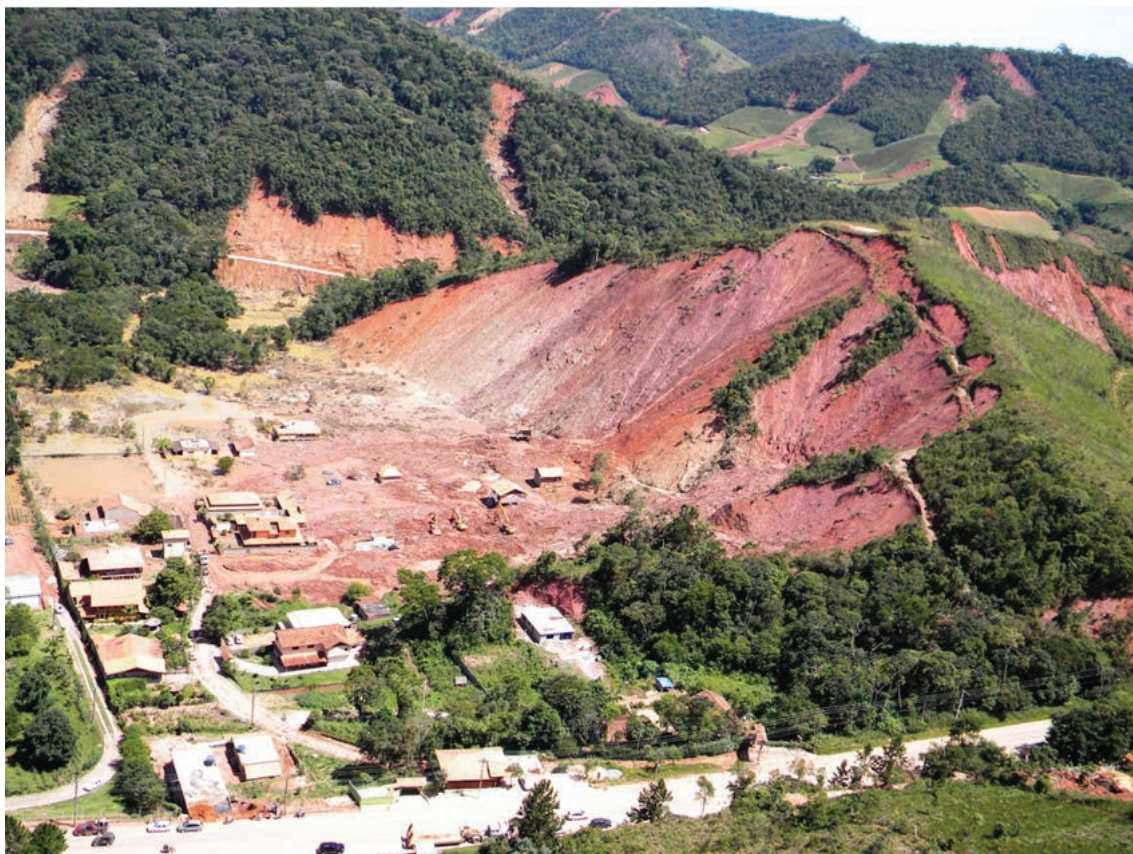
Figura 7 Fotografia de um deslizamento tipo “Catarina” no Condomínio do Lago, Nova Friburgo, RJ.
