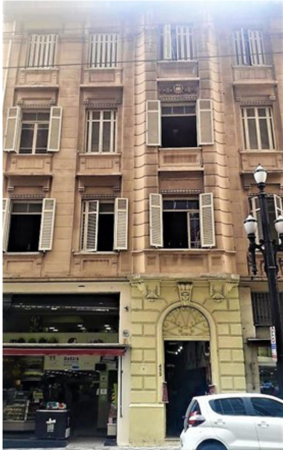
Figura 1. Rua Líbero Badaró, n. 452 (antigo n. 67), Centro de São Paulo. Fotografia realizada em novembro de 2020.
