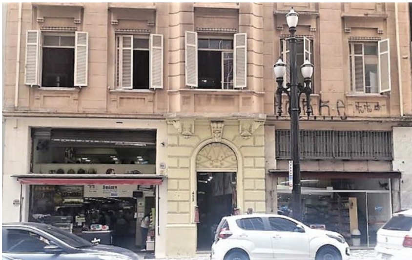
Figura 2. Rua Líbero Badaró, n. 452 (antigo n. 67), Centro de São Paulo. Fotografia realizada em novembro de 2020.
