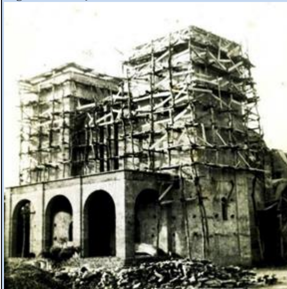
Fig.2 Construção da Catedral início de 1950
