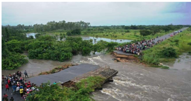
Figura 3. Estrada danificada pelo ciclone Gombe
