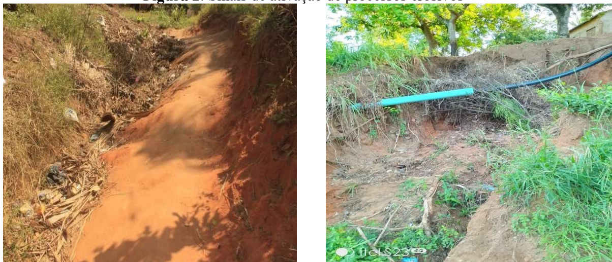
Figura 2. Sinais de ativação de processos erosivos
