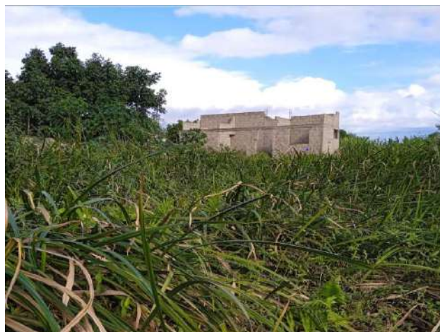
Figura 4. Construção de habitações em locais de ecossistemas sensíveis
