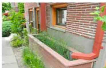
Calha desconectada
