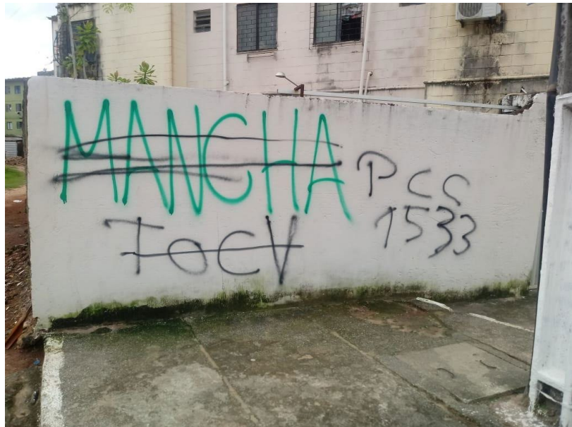
Imagem 2: Muro de um conjunto habitacional de Maceió com pichações de torcidas riscadas e sobrepostas por pichação do PCC
