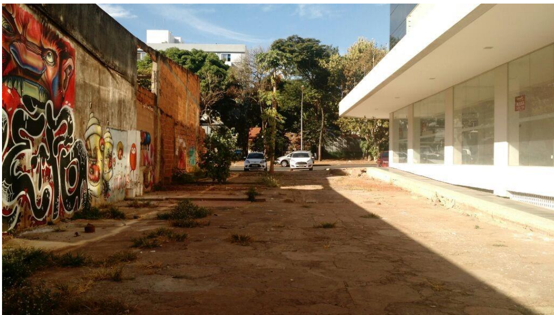
Figura 4: Vista da antiga área da Oficina Perdiz após a demolição. (foto do autor)
