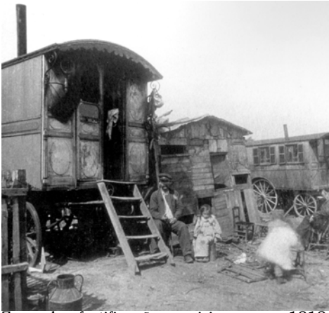
Zona das fortificações parisiense, em 1919. Foto de Eugène Atget (fonte: Dethier; Guiheux. La ville, art et architecture en Europe, 1870-1993 . Paris: Centre Georges Pompidou, 1994. p. 100).
