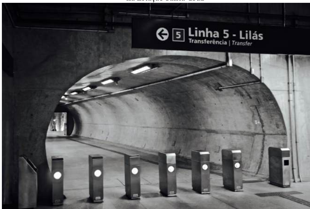
Figura 3 - Corredor de transferência entre a Linha 1-Azul e a Linha 5-Lilás na Estação Santa Cruz
