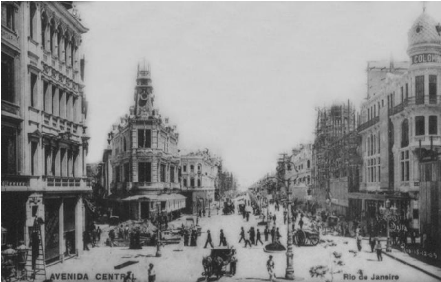
Avenida Central, Rio de Janeiro. Tomada da esquina da Rua do Ouvidor, uma das ruas mais movimentadas da cidade. Fotografia de Augusto César Malta.
