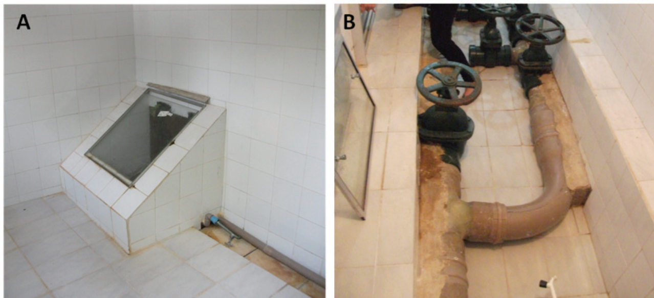
Figura 3: Edificações construídas ao redor das nascentes 6 (A) e 7 (B) da Serra de São José para captação de água para o fontanário externo e abastecimento da piscina de água termal do Balneário Águas Santas no município de Tiradentes, Minas Gerais. As águas são captadas próximas à superfície do terreno, diretamente sobre as fraturas da rocha quartzítica e armazenadas para a distribuição controlada através de bombas.
