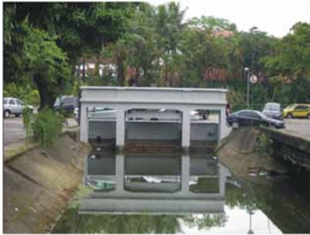
Figura 6. Vista da comporta que liga o Rio dos Macacos com a Lagoa Rodrigo de Freitas (na ocasião fechada). Comunicação franca do Rio dos Macacos com o Canal do Jóquei, por baixo da rua, na margem direita. Acervo pessoal (Miguez 2009).
