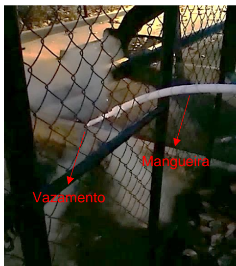
Figura 3: Vazamento de nitrogênio a partir da mangueira de um dos tanques criogênicos devido ao mau fechamento da válvula.
