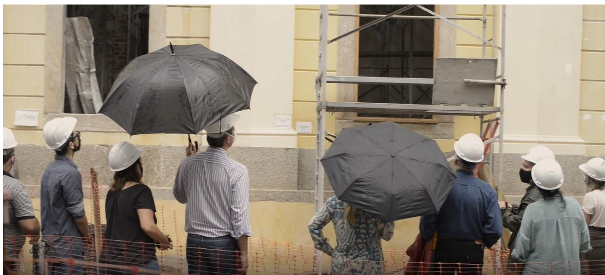
Figura 4 – Visita de parceiros às obras do Palácio
