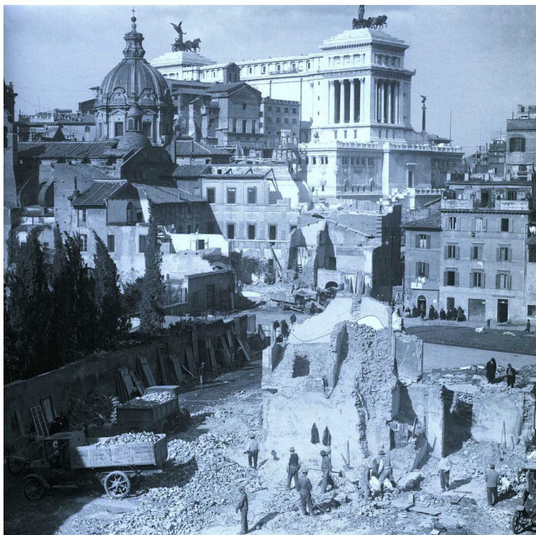
Il. 4: Demolições, em 1931, de diversos quarteirões no Bairro dos Pantani para a liberação do Fórum de Trajano.
