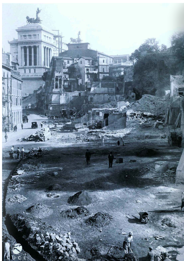
Il. 2: Demolições na Colina do Campidoglio em 1929 para a redescoberta e liberação da Rupe Tarpeia. À frente, as casas do Campidoglio diante da Igreja de Santa Maria em Aracoeli em processo de aniquilamento. Fonte: Insolera, Sette (2003, p. 56).
