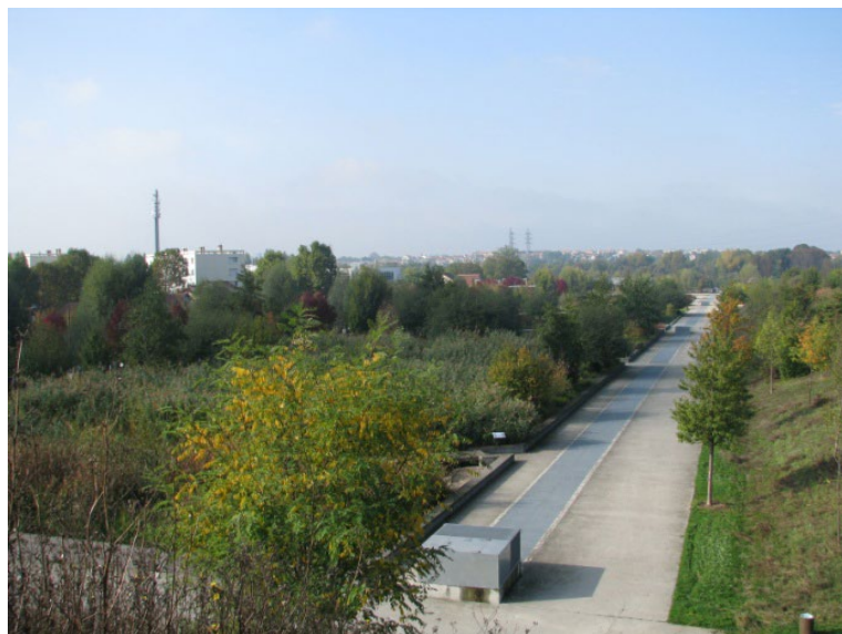
II. 1: Vista geral das bacias filtrantes. Fonte: Fotografia Ivete Farah, 2012. Acervo da Autora.
