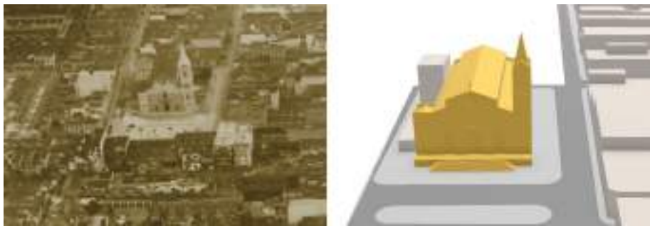
Il. 7: Igreja de Santana, antes de sua reforma. À esquerda, fotografia de S.H. Holland; à direita, sua modelagem volumétrica.
