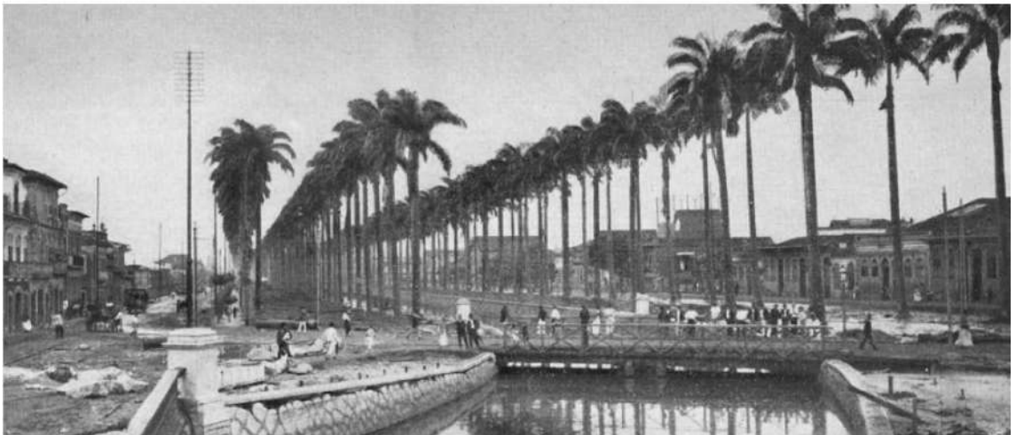
Il. 1: (a) Localização geográfica. Fonte: Elaborado pelos autores com base de fontes em IPP e MPRJ); (b) Prolongamento em direção à Av. Francisco Bicalho construída sobre aterro, Augusto Malta, 1906, Rio de Janeiro Aqui , 2022.
