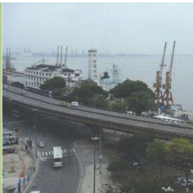
Il. 12: O espaço livre da Praça Mauá, ainda segmentado, e o Elevado da Perimetral ao fundo, em 2013.
