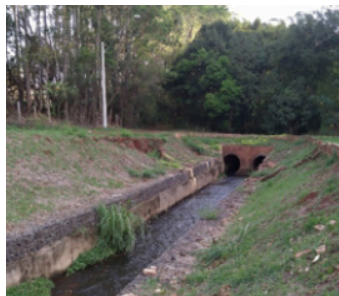
Ils. 6 e 7: Retificação e tamponamento do Córrego Bocaiúva. Fonte: Acervo das autoras, 2022.
