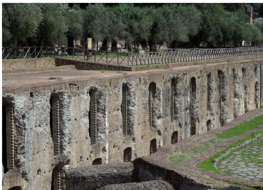
Il. 1: Conjunto llamado “Cento Camerelle” en la Villa del emperador Adriano en Tívoli (Italia), para el cual se elaboró el proyecto de restauración y reutilización como depósito de material arqueológico. Para ello se efectuaron reintegraciones de los flancos de las aberturas que permitieron colocar rejas, completamente invisibles desde el exterior. La excavación dio también lugar al descubrimiento de dos calzadas de acceso a la villa: una de servicio, conectada con los pasajes subterráneos, y otra a un nivel más alto, de tipo ceremonial. Proyecto: M. Manieri Elia, con G. Manieri Elia, M. M. Segarra Lagunes, 1997-2002.
